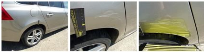
Door R L, Repaired, P - Check
