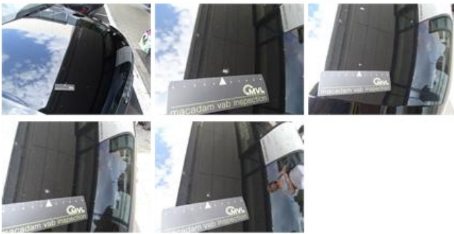
Door R L, Repaired, Acceptable
