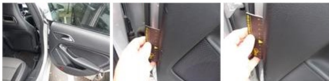
Door R R, Repaired, P - Check
