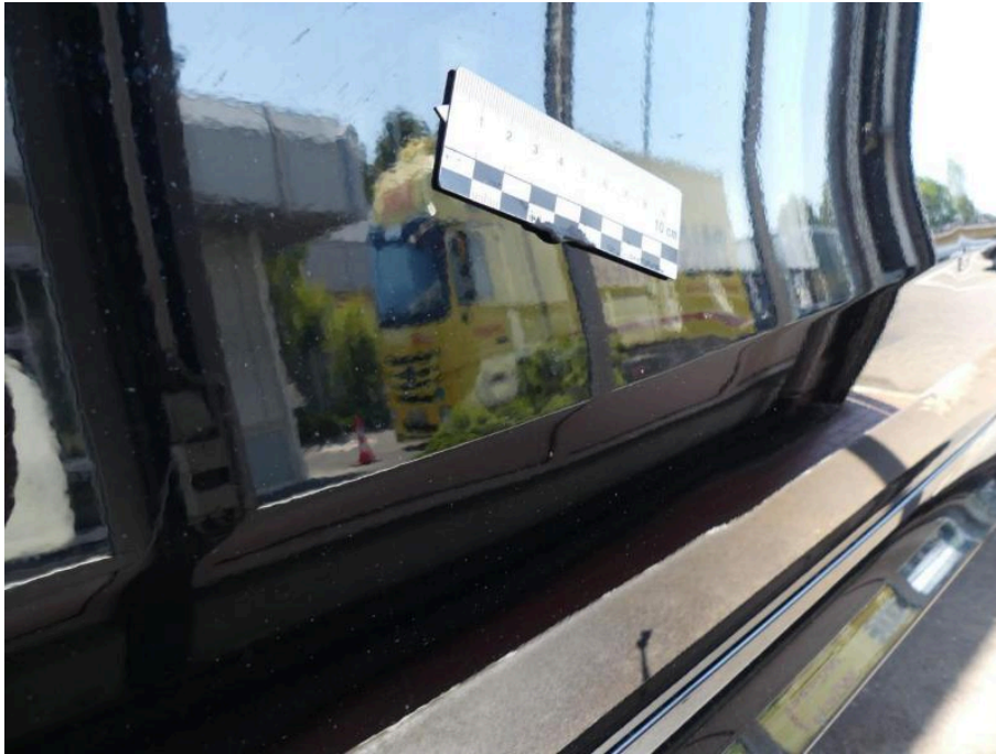
Bild 33 linke Seite Tür vorne links verformt
