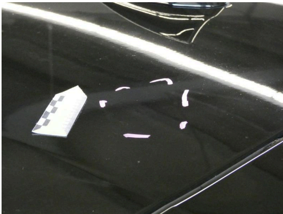
Bild 23 Dach Dachhaut verätzt
