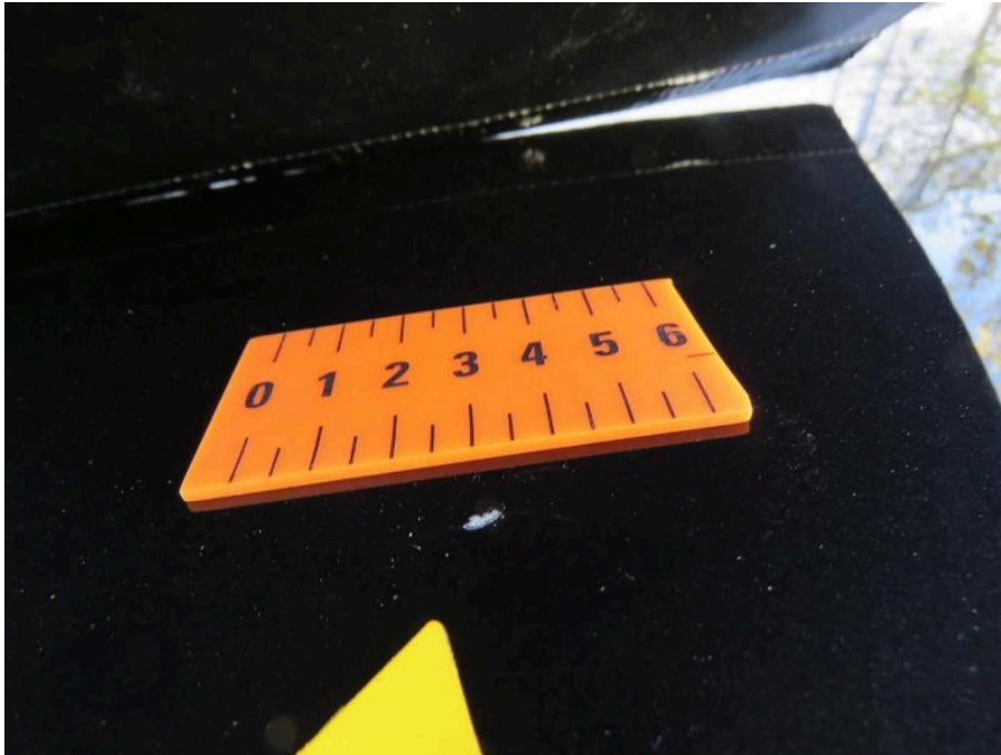
Bild 49 Dach Dachhaut Steinschlag / -schläge
