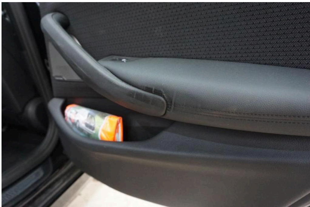
Bild 17 Innenraum Türinnenverkleidung hinten rechts Armlehne rechts und links hinten Druckstelle durch Reifen
