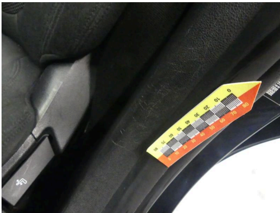
Bild 19 Innenraum Innenraum abgegriffen
