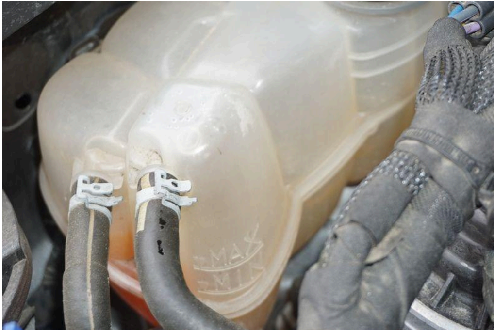
Bild 36 Wartung/Prüfung Kühlflüssigkeit Ausgleichsbehälter leer, auffüllen, erkennbar
