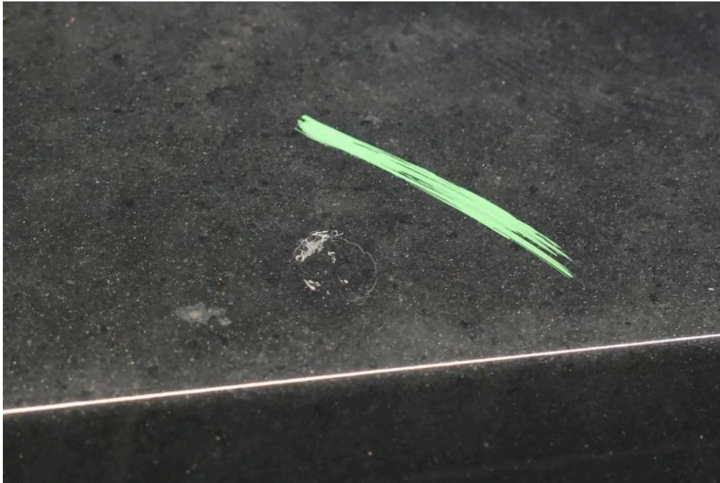
Bild 45 Dach Dachhaut Dellen/Vogelkotanhaftungen/Steinschlag
